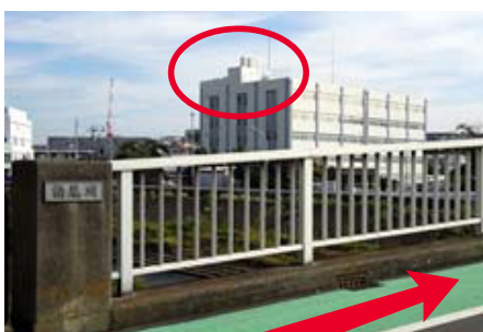
5 2本目の橋で柏尾川を渡ります。橋を渡ると日立産業制御ソリューションズ横浜事業所B棟があります。
